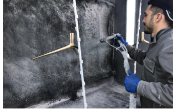
Applicazione verniciatura trasparente
